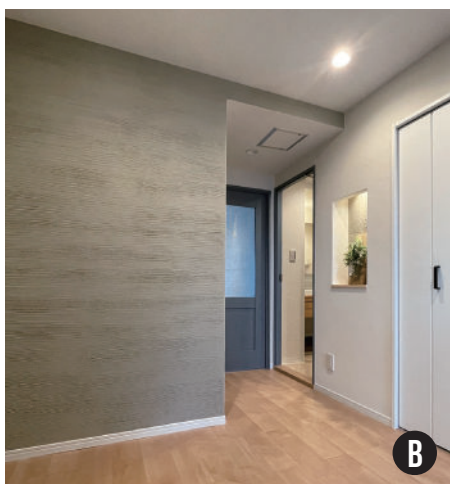
HALL 存在感のある珪藻土の櫛引仕上げ。
